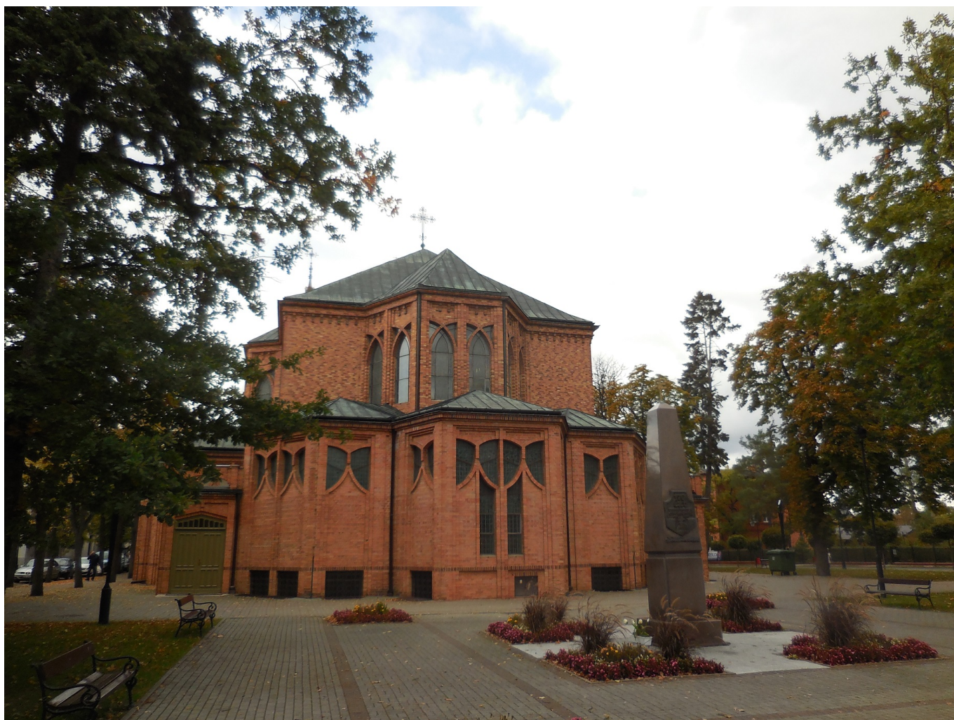
Rozbudowa: transept, prezbiterium, zakrystia; fot.: https://www.tuhistoria.pl/wp-content/uploads/2021/03/DSCN7546.jpg (dostęp 29.12.2024)
