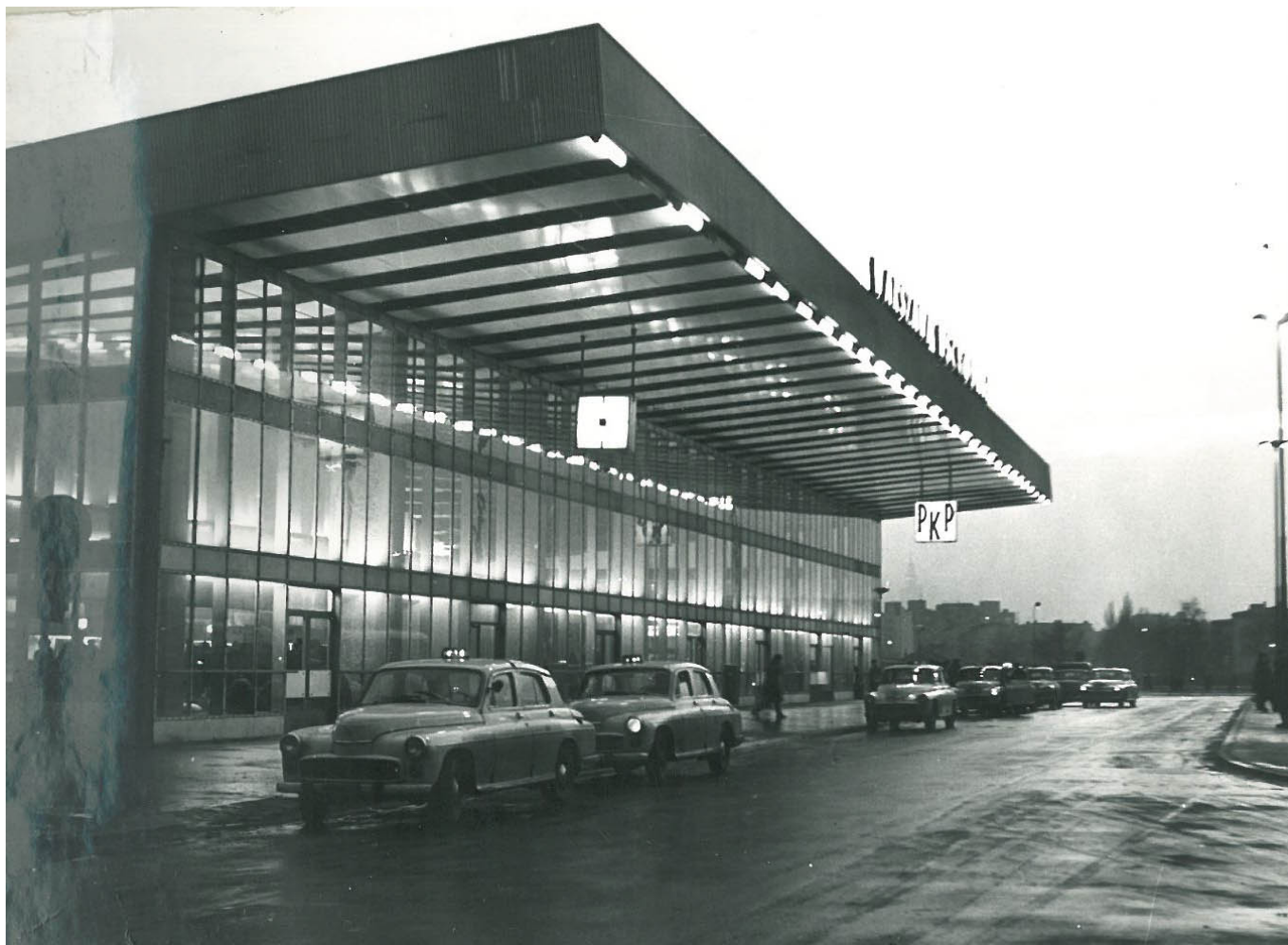
Dworzec Warszawa Wschodnia, od ul. Kijowskiej, dworzec dalekobieżny; fot.: Arseniusz Romanowicz, archiwum SARP
