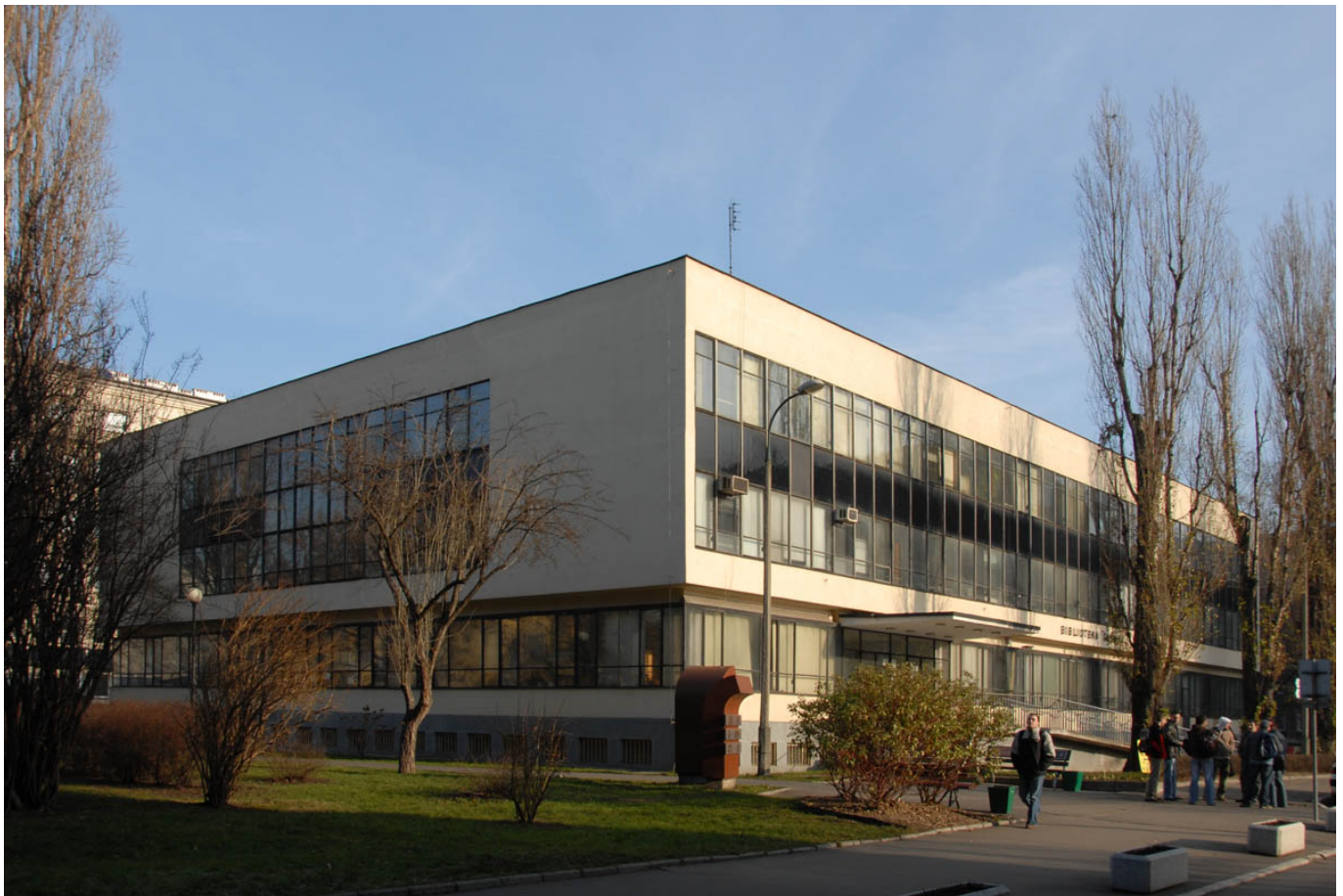
Biblioteka Główna Akademii Górniczo-Hutniczej w Krakowie; fot.: http://archibaza.pk.edu.pl/bazarch/files/29/DSC_1008.JPG
